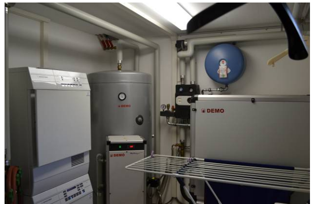
Locale tecnico e lavanderia
