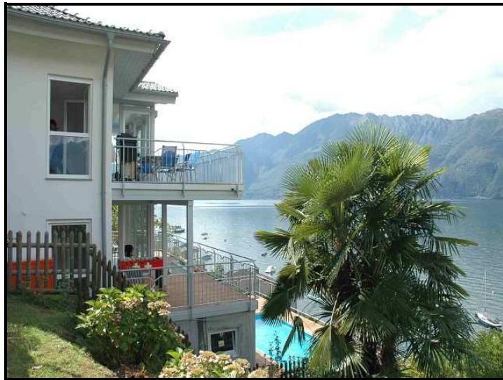
Facciata est / Ostfassade
