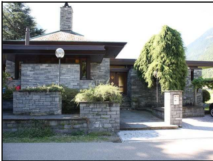
Facciata nord con entrata / Nordfassade mit Eingang
